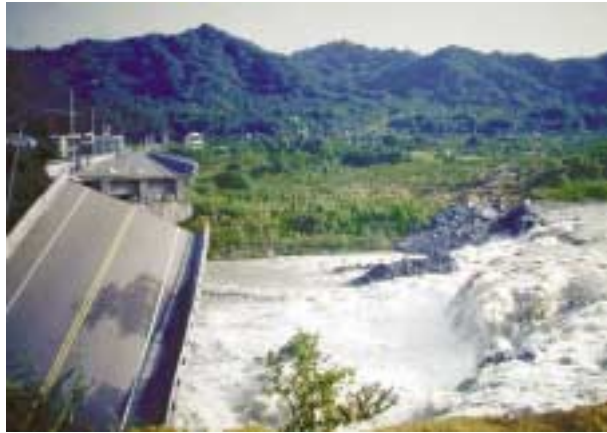
斷橋及瀑布 引發九二一集集大地震的車籠埔斷層，穿過豐原和東勢之間的大甲溪。地震發生時，斷層的上盤向西衝到左方的下盤之上，抬出了一道5公尺高的斷崖，形成一條瀑布，斷層旁的埤豐橋則隨之震落。
