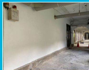
粉刷完成的廊道大牆
