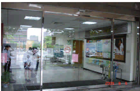
附圖：大門已裝設完成。
