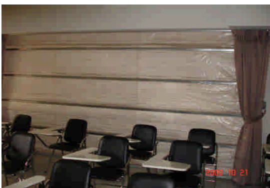
附圖：249 教室隔間已裝設完成。
