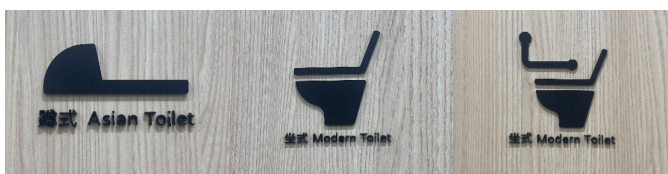
臺灣大學圖書館，使用浮凸式便器標示，便於視障者使用。最右邊者，為有扶手的坐式馬桶。
