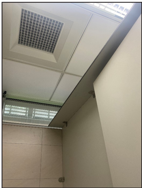
臺灣大學綜合教學館：隔間搗擺上方加裝一橫向的木板以增加偷拍之難度。
