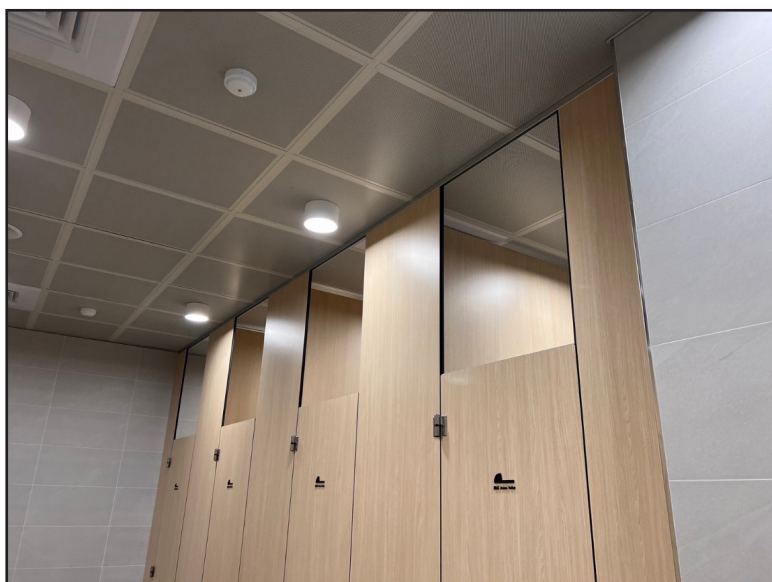
臺灣大學圖書館一樓性別友善廁所
