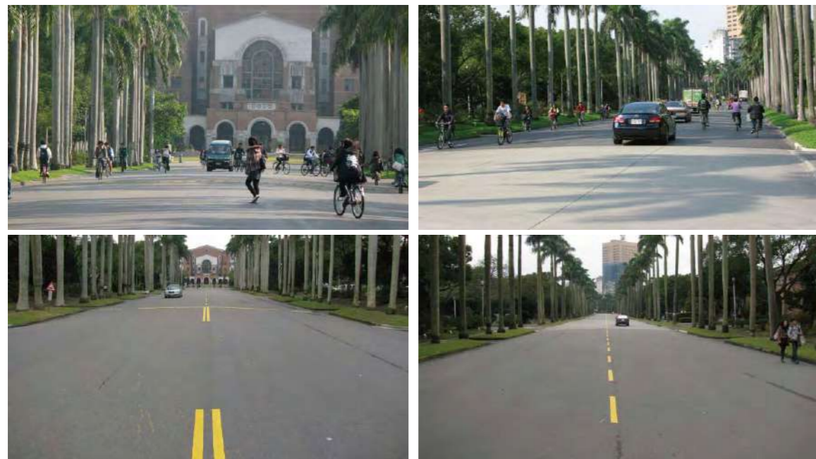
上：改善前 下：劃設中央分向標線後
