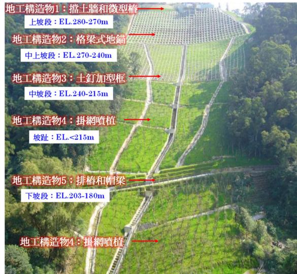
圖四 貓纜T16塔柱整治使用之地工構造物配置示意圖
