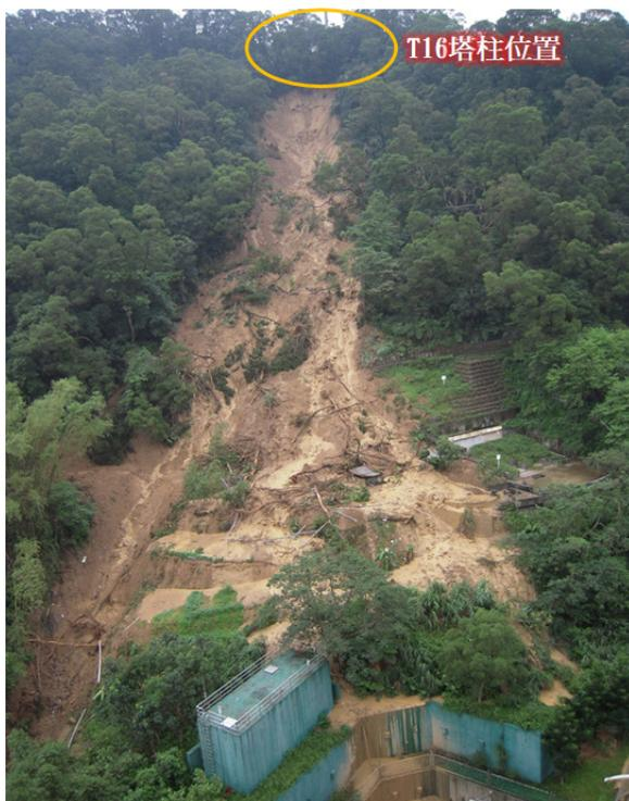
圖二 貓空纜車T16塔柱下邊坡崩塌現場照片 (陳仁達技師提供)
