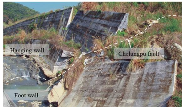
圖三 剛性混凝土擋土牆於集集地震時因地表變形發生破壞
