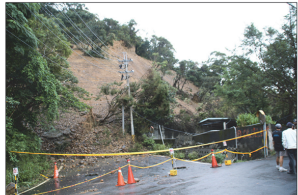
圖十三 新光路邊坡災後現場照片(青山工程顧問股份有限公司，2009)
