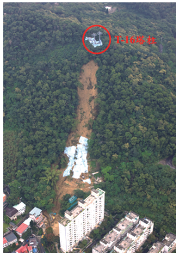
圖二 貓纜邊坡崩塌現場照片(齊柏林攝)
