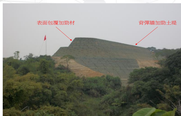
圖 4 戰車砲射擊訓練場背彈牆加勁土堤
