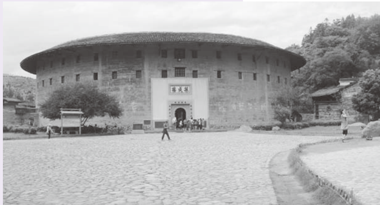
▼福建省永定縣傳統客家建築—客家土樓
