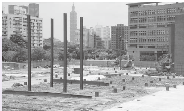
▲社科院新建工程開挖
