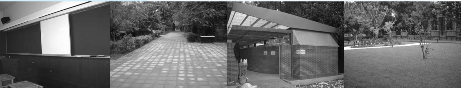
▼ 徐州院區新建四工程：教室e化、透水磚景觀步道、廁所改建與綠地景觀改善
