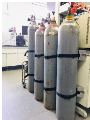
鋼瓶。每一鋼瓶配有鋼瓶座固定
