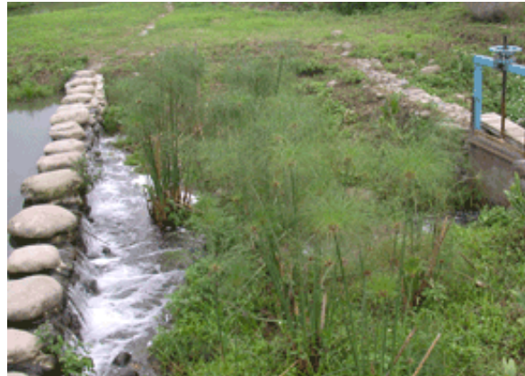
濕地植物淨化池
