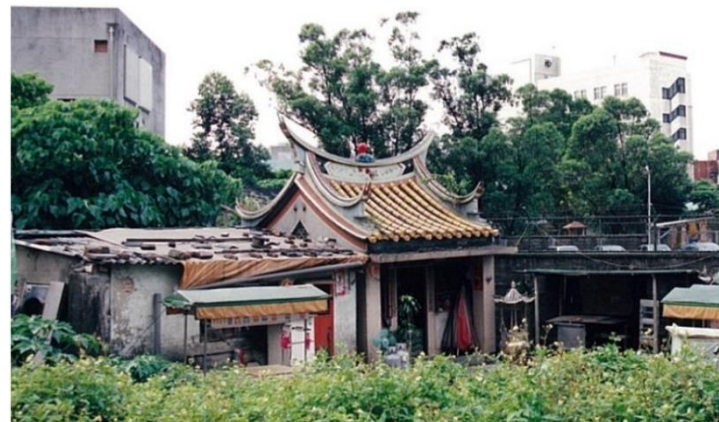
原福德宮(已拆除)
