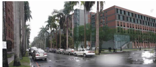
完工後之工綜館
