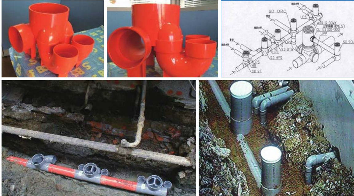
汙水管設計：加裝存水彎，防止臭味之功能最佳化設計，有助於水流通暢
