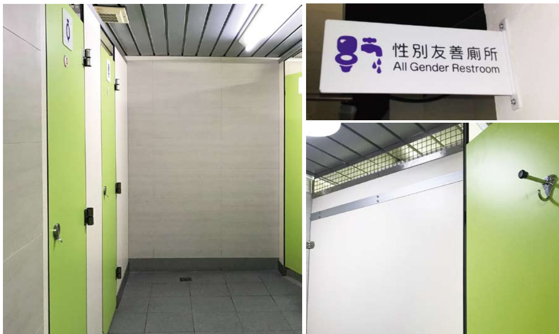
國青宿舍性別友善廁所完工照片
