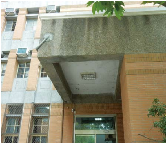
雨遮漏水明顯改善
