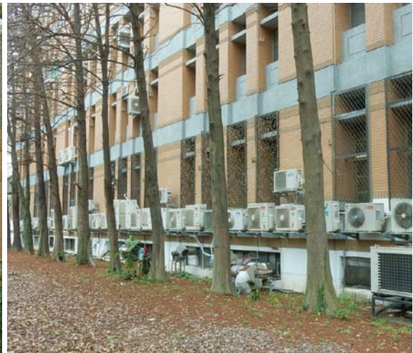
冷氣室外機安裝位置整齊、管線重新整理
