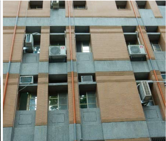
外牆增設冷氣排水管線
