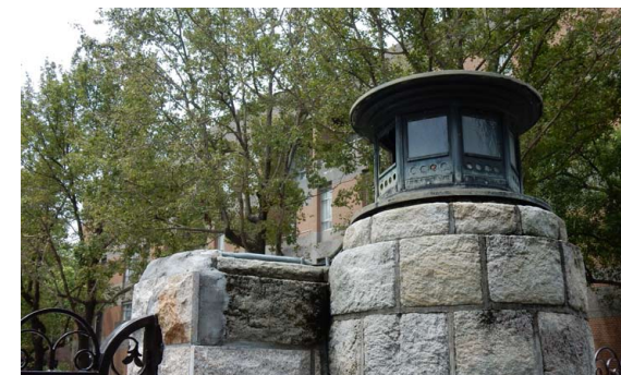
門柱燈片破損，依原式樣予以修補
