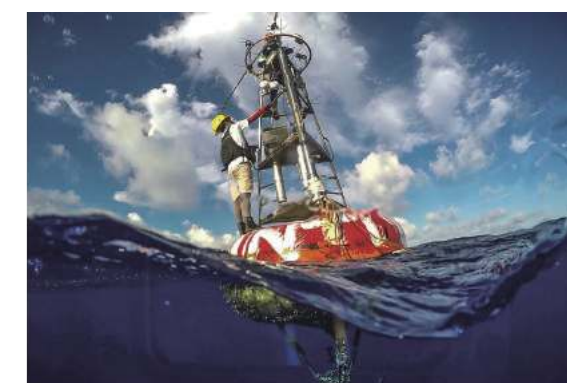
►貴重儀器中心技術員正在維護西北太平洋中的海氣象颱風觀測浮標。
