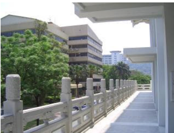
圖 5 鹿鳴堂二樓戶外露台經整修後可供利用
