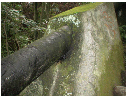
圖 13-6 第一接續井和第一水管橋之間的導水鐵管（直徑 30.3 公分，有混凝土塊 筆者 2008.7.1 攝）
