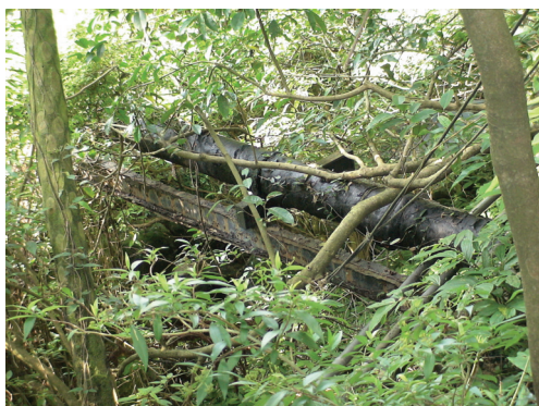
圖 13-5 緊鄰基地東北側的第二水管橋（它的構造與第一水管橋相似，但無步道連接，目前埋藏在溪谷的樹林間，並且支架已經腐蝕嚴重 筆者 2008.7.1 攝）
