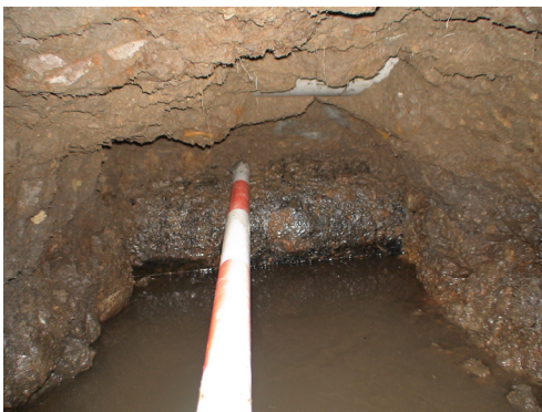
圖 13-4 TP2 坑西牆內的導水鐵管（直徑 30.3 公分）
