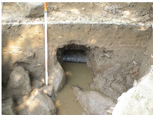
圖 13-1 TP1 坑東牆內的導水鐵管
