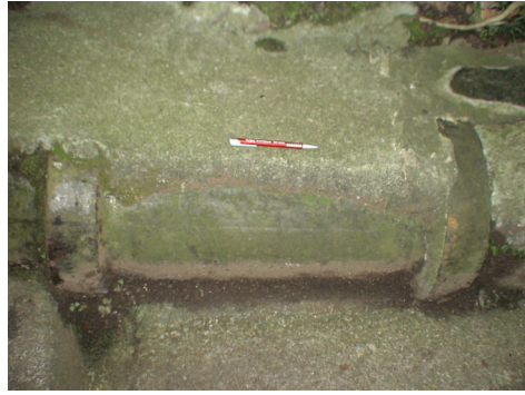
圖 14-2 第一接續井和第一水管橋之間的水階梯近頂部所露出的陶製水管(左圖放大, 陶管長約 60 cm 郭素秋 2008.7.1 攝)
