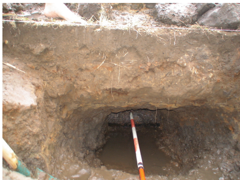
圖 13-3 TP2 坑西牆內的導水鐵管（直徑 30.3 公分）
