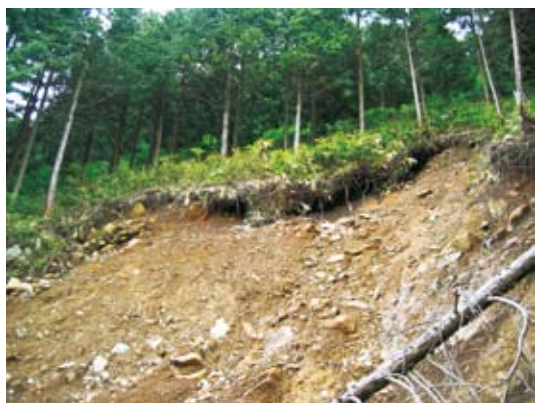
圖2 淺層崩塌跡地與樹木根系(梁偉立 攝於日本京都府宮津市)
