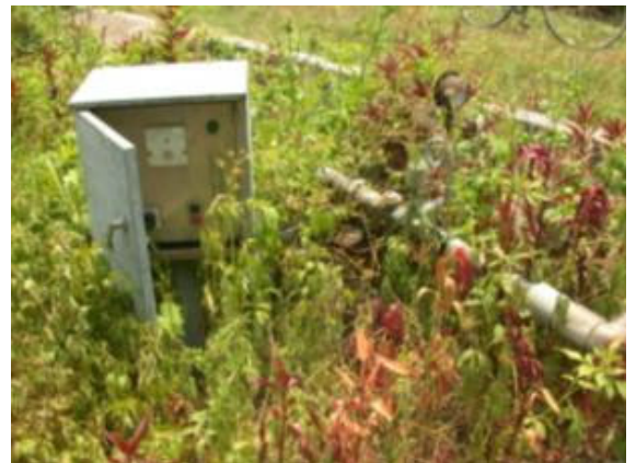
照片 5 農場三號水井原貌（目前在水源池下方）
