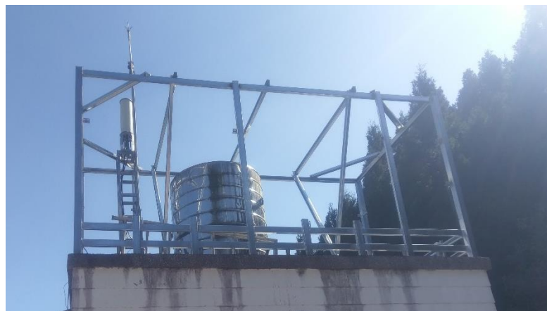
基地台設備架設中 ( 照片拍攝於2/16 )
